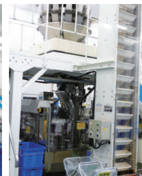
落下してくる途中で金属検出器と通過する
